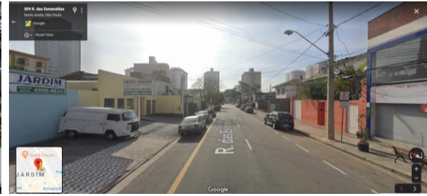
Fig.6 Vista do trecho 16 (Rua Esmeralda) Fonte: Google Street View
