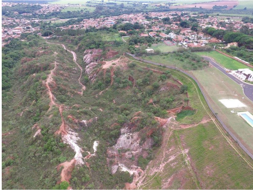
Figura 8 – Vista do ramo principal da boçoroca Senhor Menino
